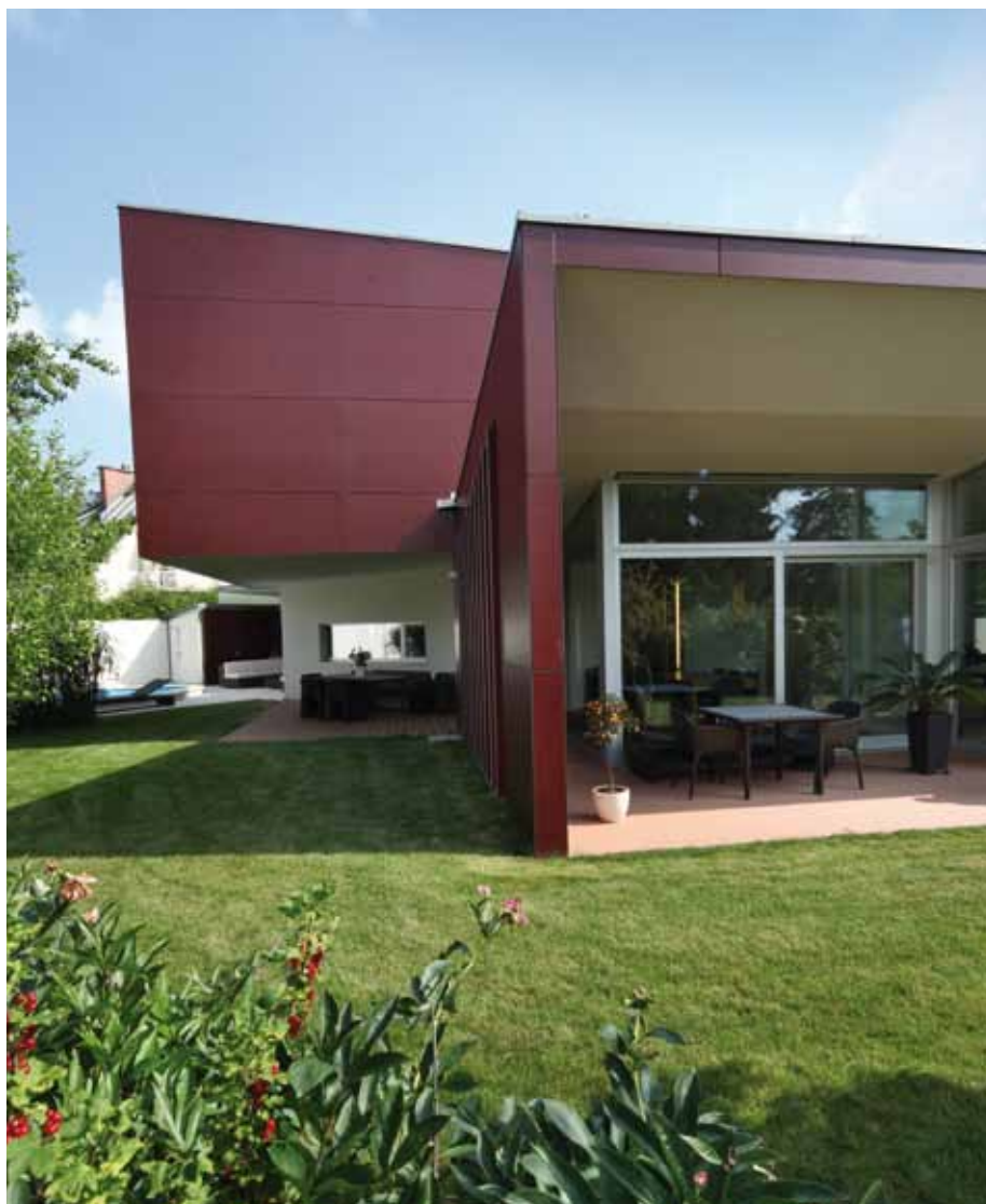
Die Fassadenplatten mit Holzdekor wurden gänzlich geklebt. Damit gibt es keine optische Beeinträchtigung durch störende Schrauben und Leisten.
